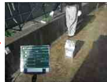
プライマー塗布
