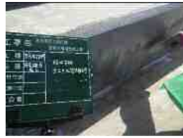
モルタル薄塗り
